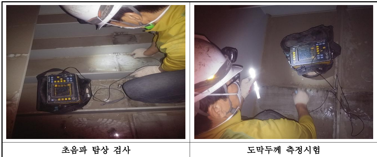
【사진 3.27】 강재 내구성조사 전경
