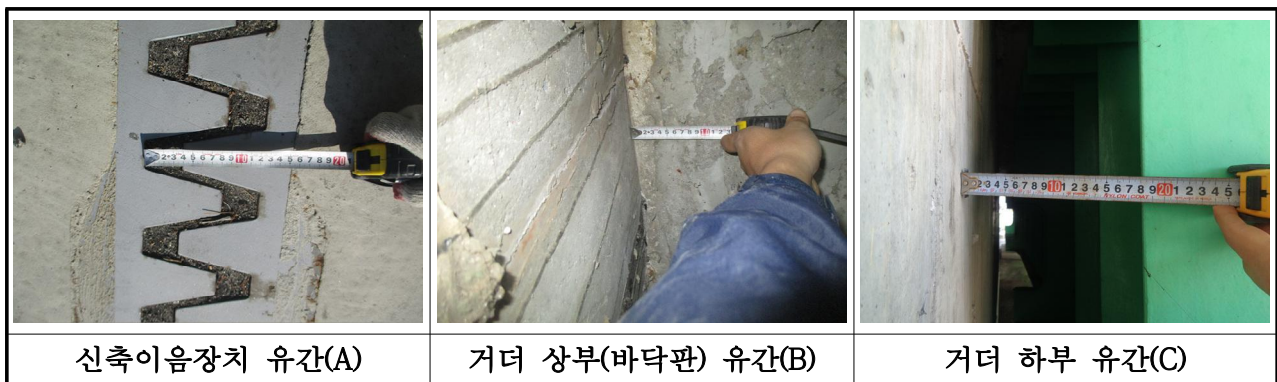
【사진 3.19】 신축이음 유간 측정방법
