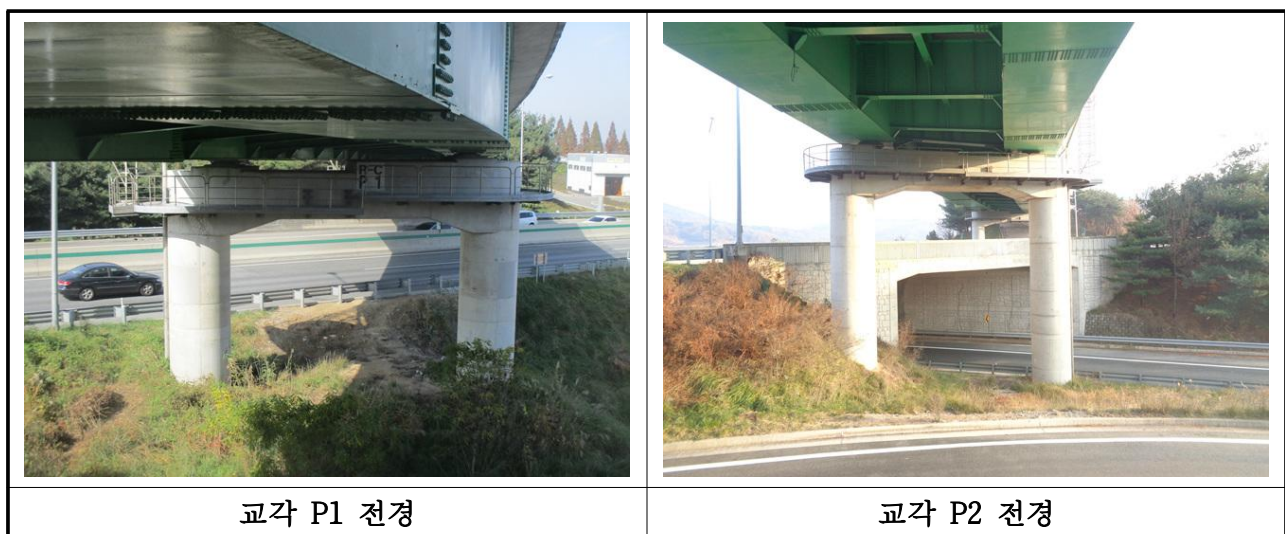
【사진 3.13】 교각 전경
