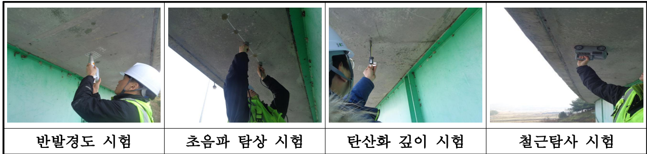
【사진 3.26】 콘크리트 내구성조사 전경
