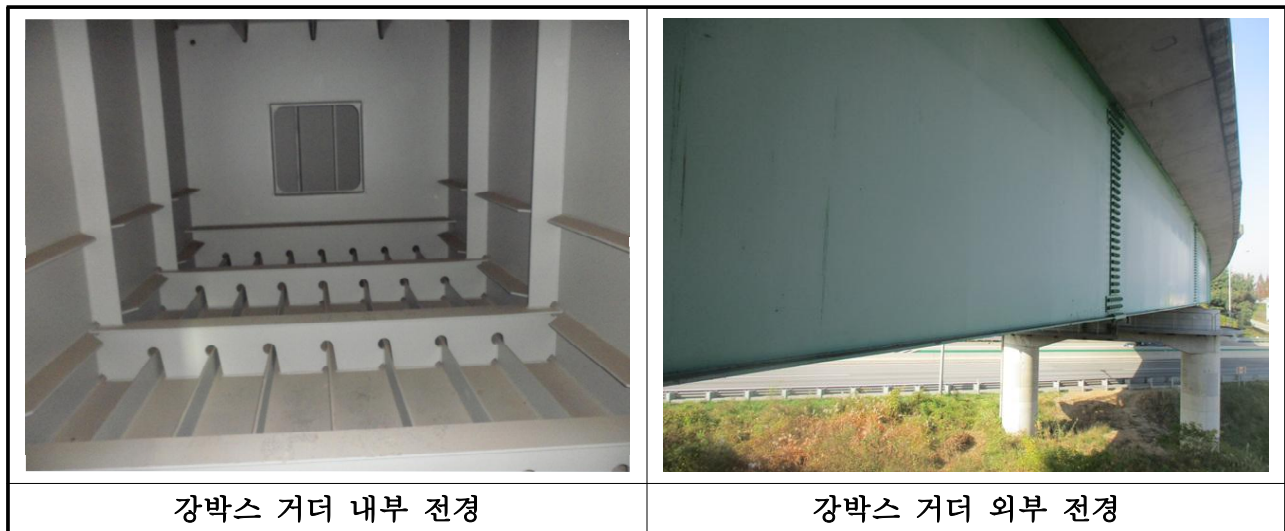
【사진 3.5】 강박스 거더 전경
