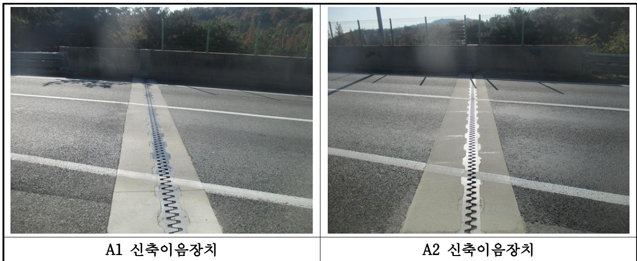
【사진 3.17】 신축이음장치 전경
