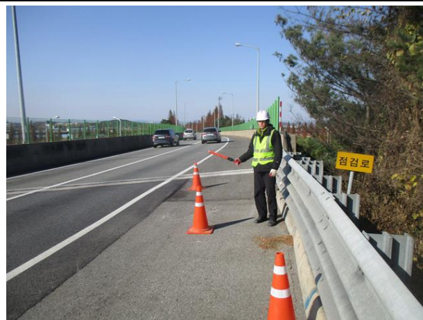
교통통제 후 교면포장, 방호울타리 조사
